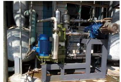
螺桿真空泵代替水環真空泵
