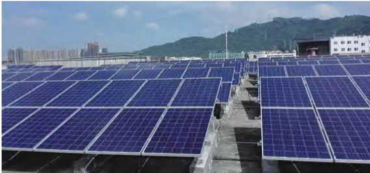
中一藥業在廠房頂部安裝太陽能光伏發電設施，月發電量超過70萬千瓦時，每年折合減少溫室氣體排放超過5,000噸二氧化碳當量。
